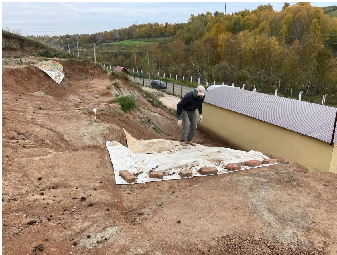
Рис. 2. Укладка баннерами участка в квадратах D (-3)-D (-4)
