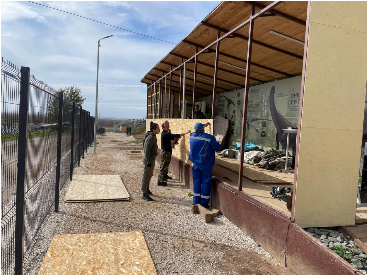
Рисунок 3 Обшивка OSB листами выставочного павильона на зимний период
