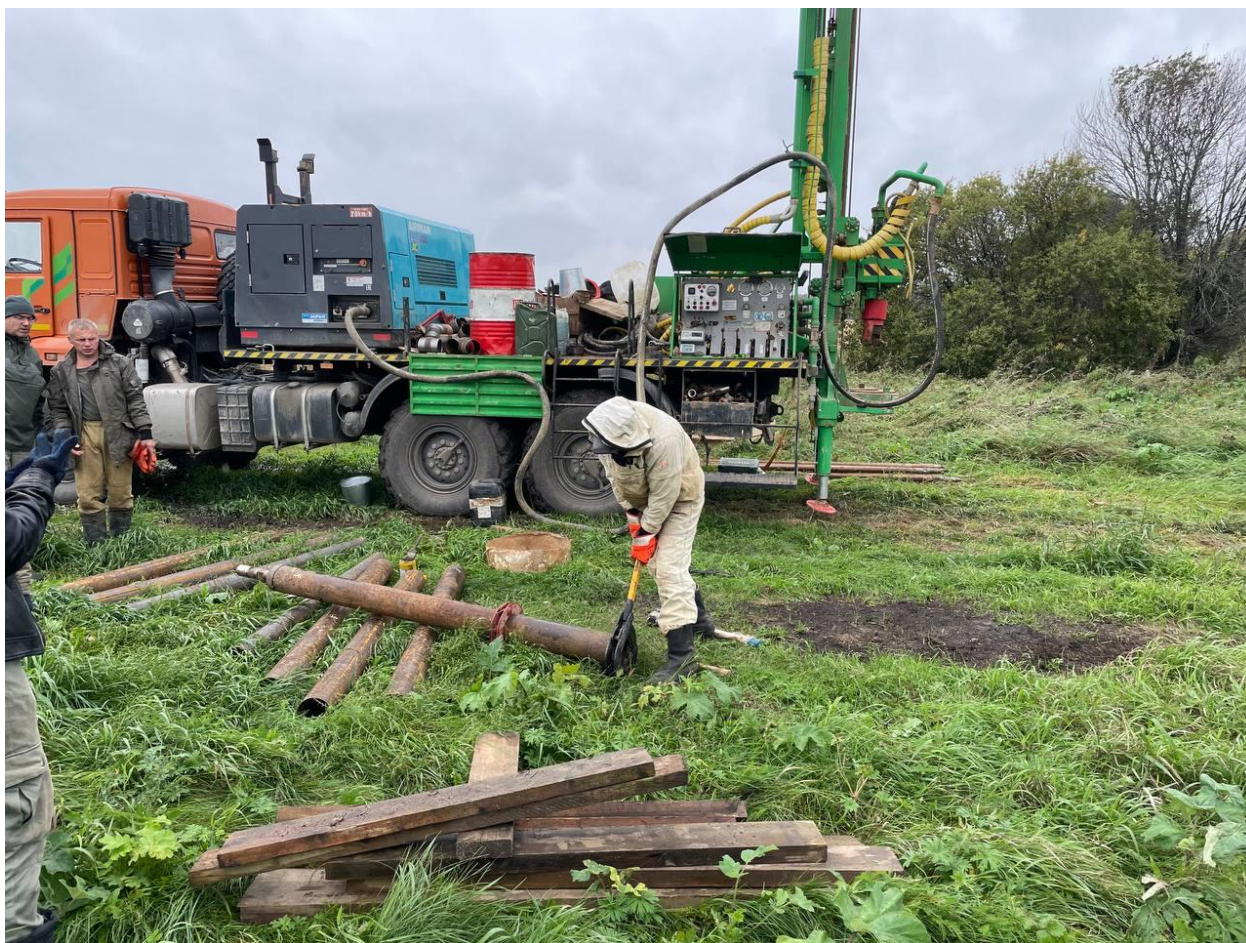
Рисунок 3 Подготовительные работы к бурению, установка колонны
